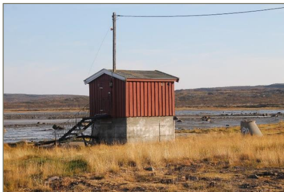
Figur 11. Eksisterende renseanlegg like ved flomålet. Dette bygget og annen synlig infrastruktur fra dagens anlegg skal saneres og fjernes fra området. Foto: Rambøll
