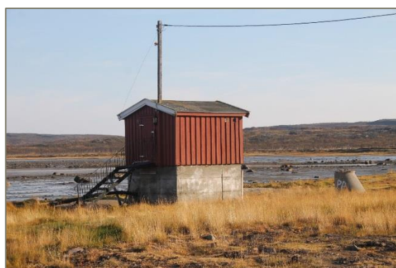
Figur 11. Eksisterende renseanlegg like ved flomålet. Dette bygget og annen synlig infrastruktur fra dagens anlegg skal saneres og fjernes fra området. Foto: Rambøll
