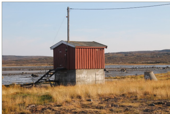
Figur 10. Eksisterende renseanlegg like ved flomålet. Dette bygget og annen synlig infrastruktur fra dagens anlegg skal saneres og fjernes fra området. Foto: Rambøll
