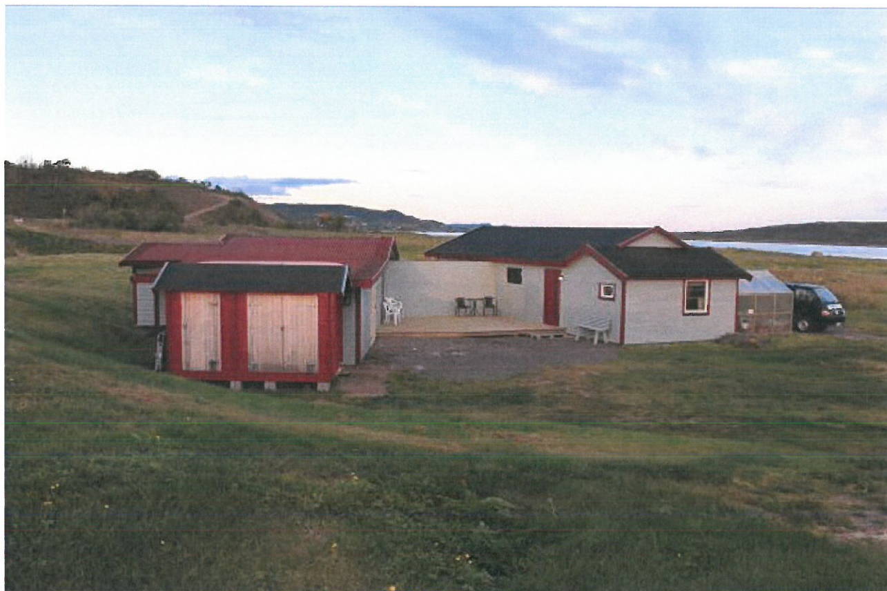
Eksisterende hytte med tilbygg 1.
