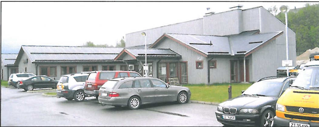
Resepsjon og adkomst Statens Vegvese. Fasader mot nord og vest
